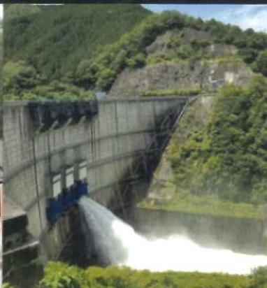
矢作ダム YAHAGI DAM
